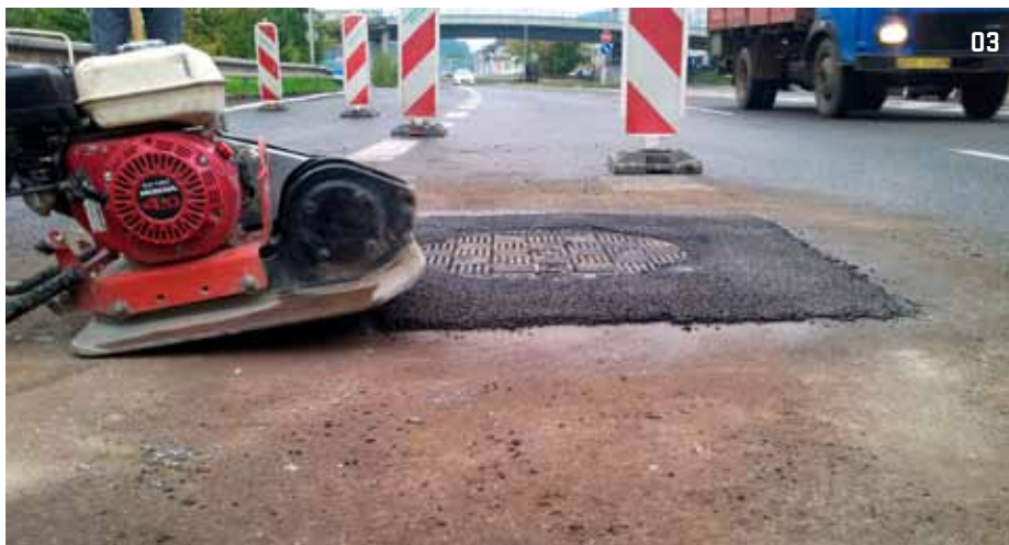
03 > Bohemix je vhodný i na opravy kolem kanálových vpustí
