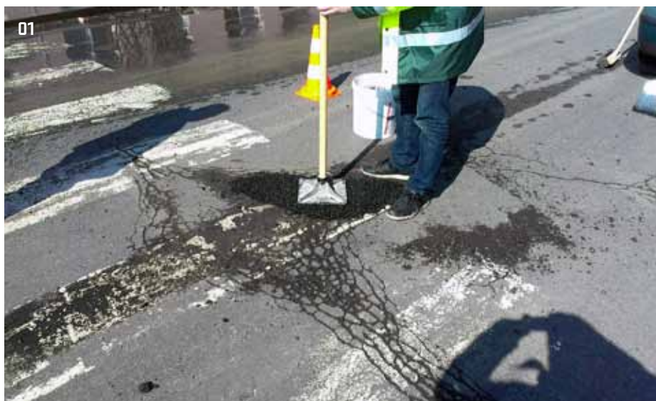
01 &gt; Při opravě není potřeba žádná drahá mechanizace
